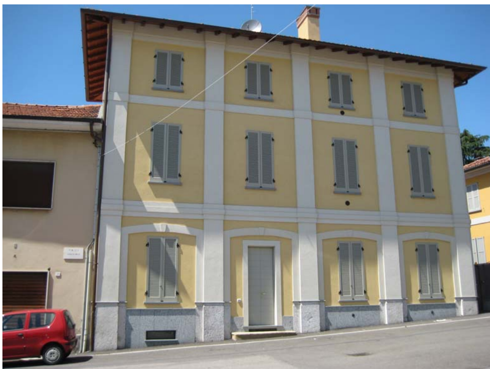
Figino S. - Edificio prospiciente Piazza Umberto I (lato nord)
