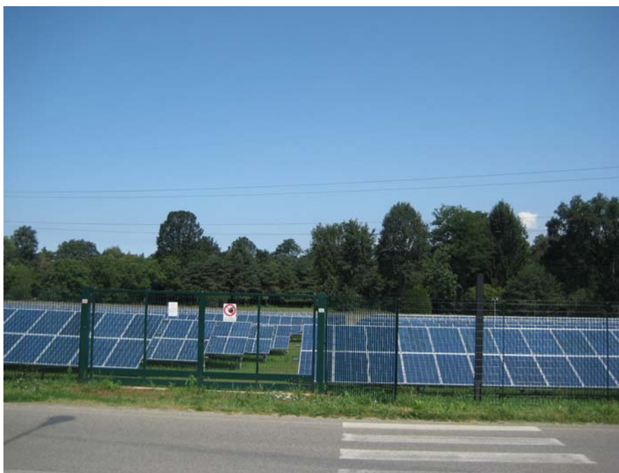
Figino S. - Varco della Rete Ecologica Regionale in Via Meroni (lato nord) allo stato occluso dall'installazione di un "parco fotovoltaico"
