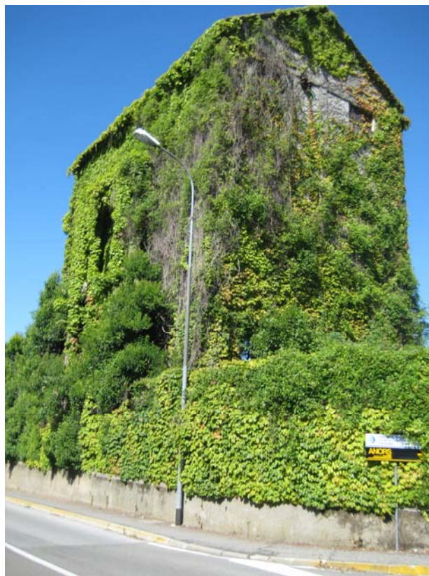
Figino Serenza – Cabina di trasformazione dell'energia elettrica di Via Europa
