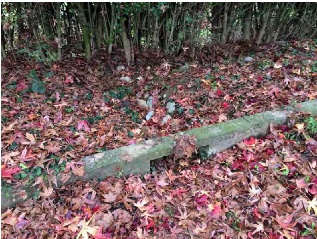
Tratto B1 - canaletta di scolo
