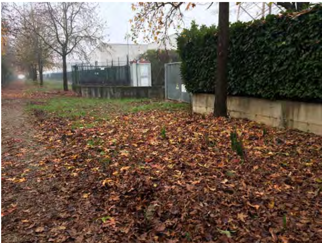
Tratto B2 - ingresso sottostazione enel
